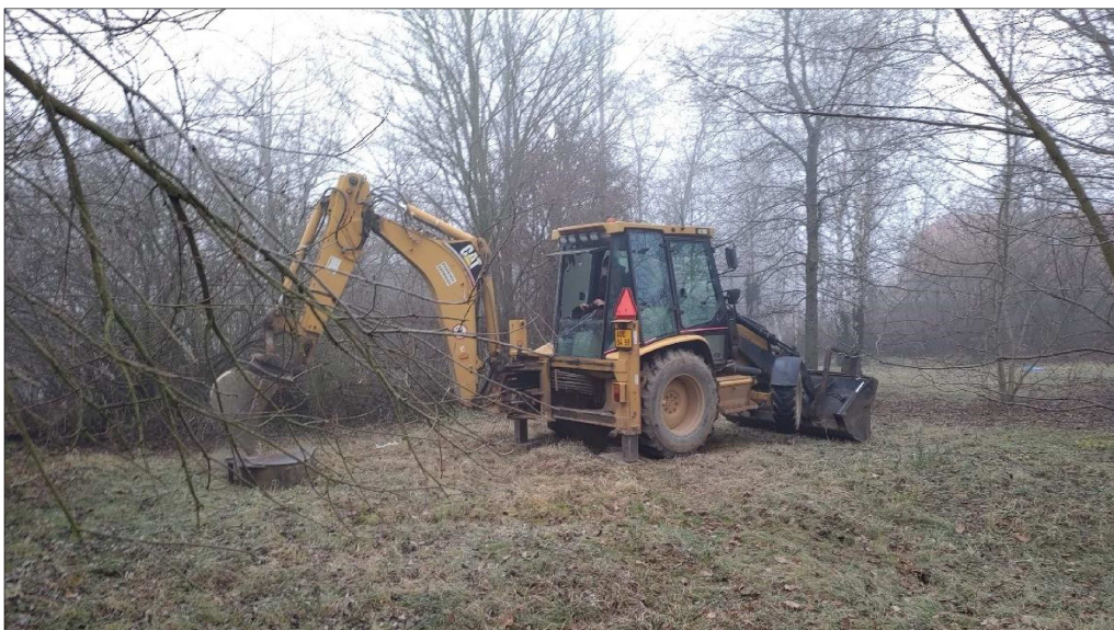
Obrázek 4: Provádění kopané sondy KS1 mechanizací - Traktorbagr CAT
