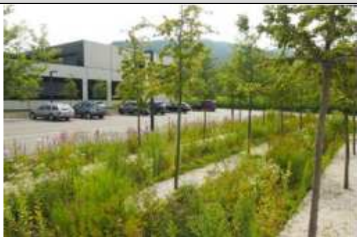
Osázená vsakovací retenční rýha s površovým přítokem, Villach, Rakousko
