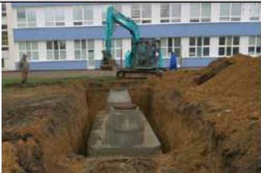
Podzemní retenční dešťová nádrž – betonová nádrž, Praha 4
