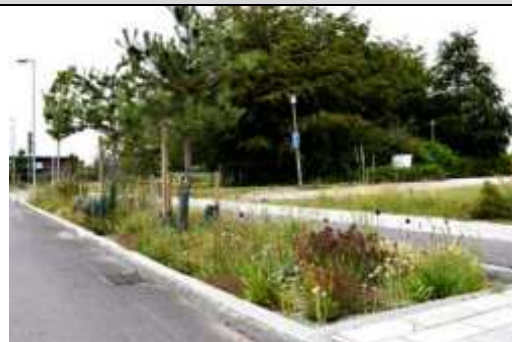
Osázená vsakovací retenční rýha s podpovrchovým přítokem, Vellinge, Švédsko
