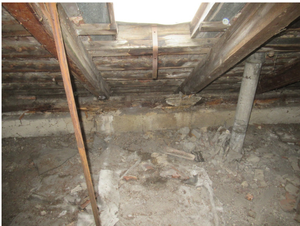
Poškozená pozednice pod krokvi č. 3-5
