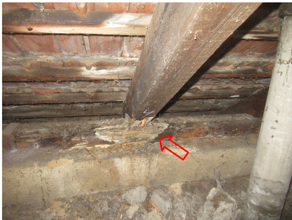
Krokev č. 4, místo odběru vzorku mv1, plodnice houby Vuilleminia comedens
