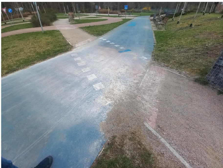
NAPLAVENINY NA DRÁZE V KŘÍŽENÍ PĚŠÍCH CEST
