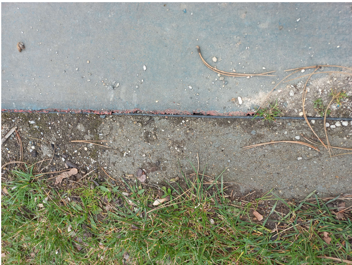
OBRUBA Z LITÉHO BETONU O Š. 125 MM
