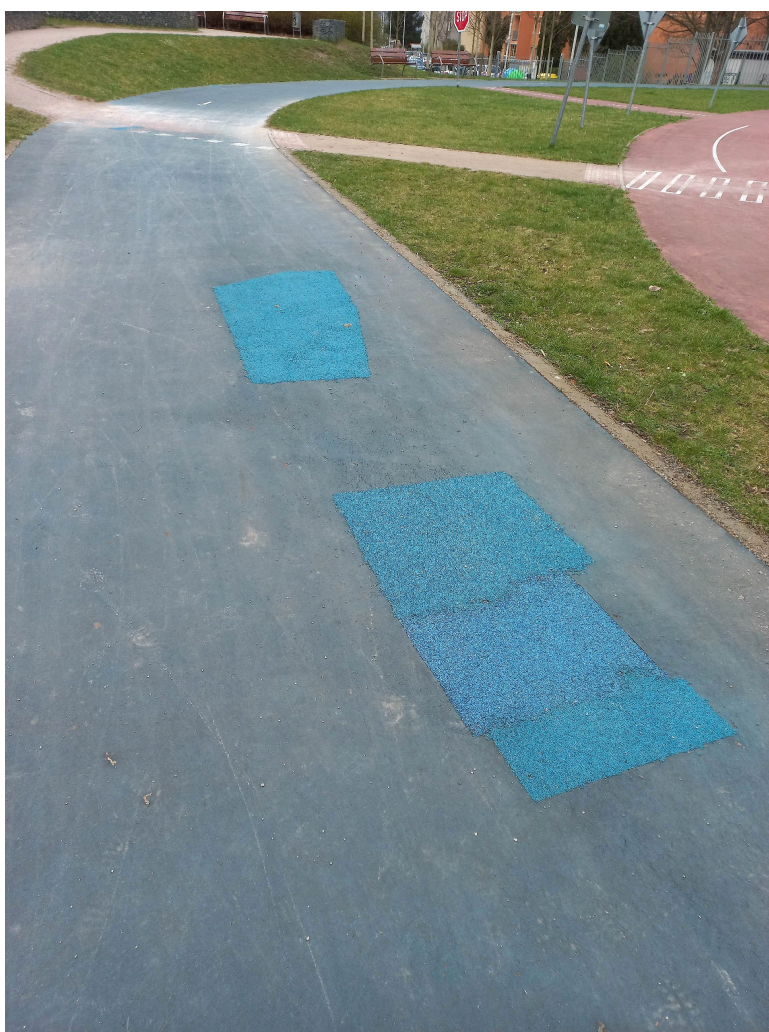
LOKÁLNÍ OPRAVY POVRCHU IN-LINE DRÁHY
