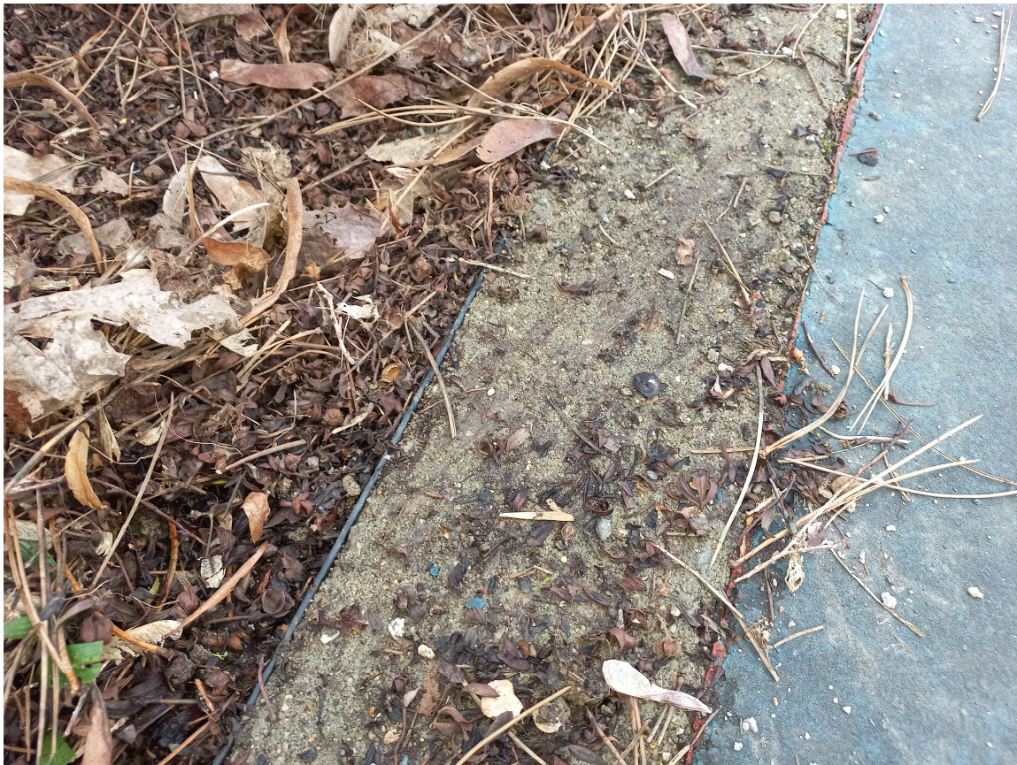
OBRUBA Z LITÉHO BETONU O Š. 125 MM
