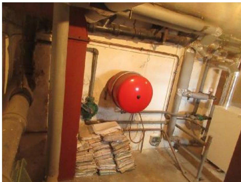
FOTO 8: Na jižní stěně sklepa jsou umístěny instalace, pod kotlem je jímka na spodní vodu obsluhovaná ručním čerpadlem. Jímka je suchá.
