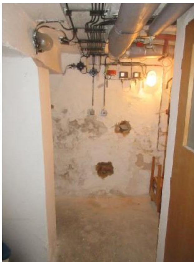
FOTO 14: Jižní stěna chodby se sondou Bau 4 (nahore) a sondou V8 (u podlahy)
