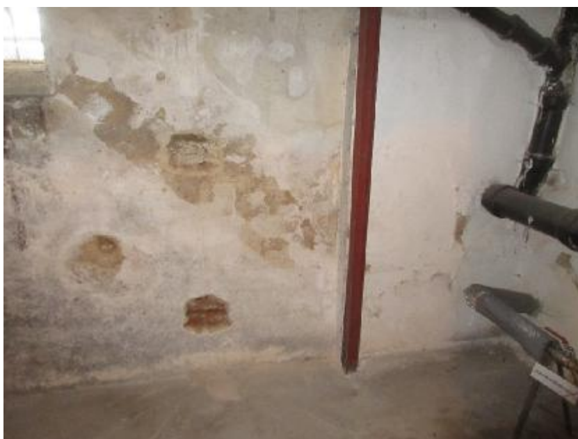
FOTO 13: Severní stěna sklepa s horní a spodní sondou V2 a sondou Bau 1 vlevo.
