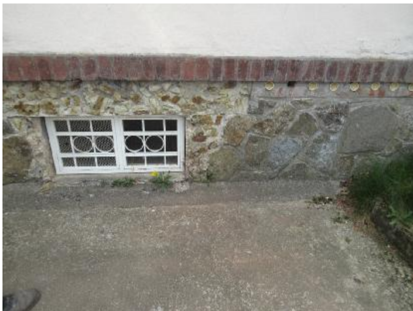
FOTO 3: Na severní straně je směrem k župě osazena mříž bez okna
