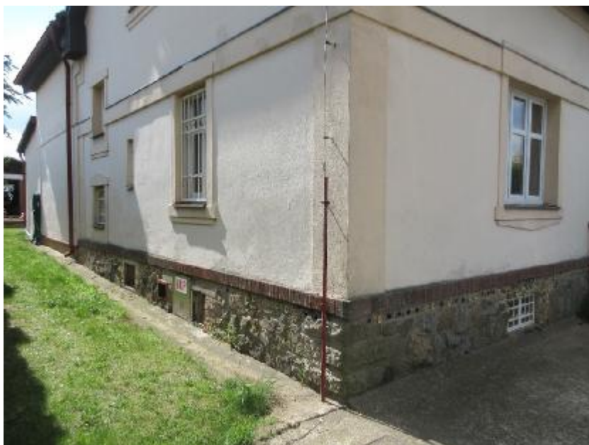
FOTO 2: Pohled na SV nároží domu: vpravo objekt žumpy, vlevo betonový žlab
