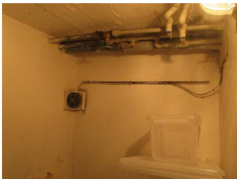
FOTO 10: Pohled do skladu s ventilátorem zaústěným do komínového průduchu
