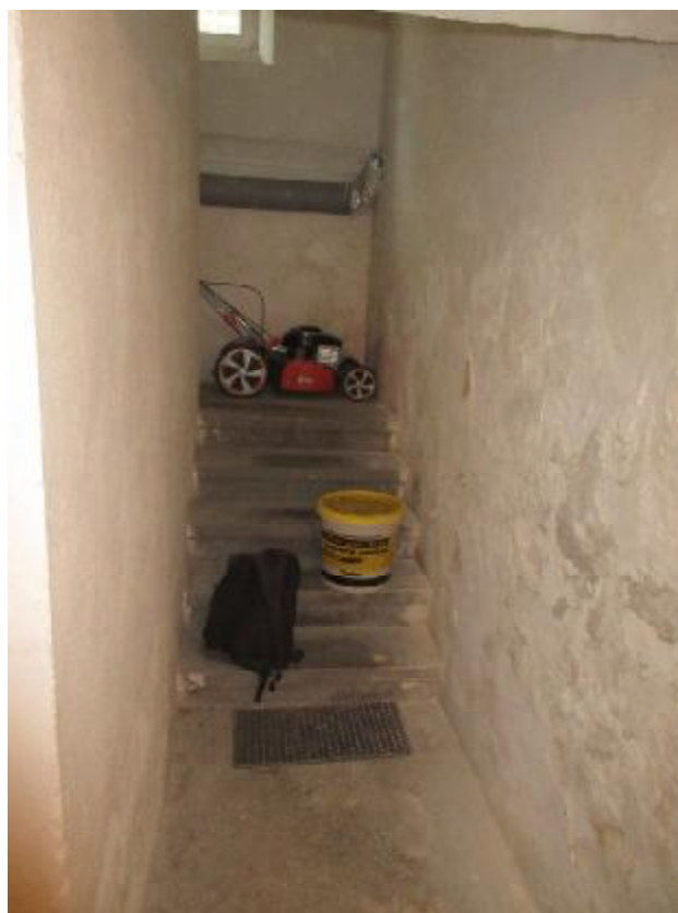
FOTO 12: Jižní stěna chodby u schodiště
